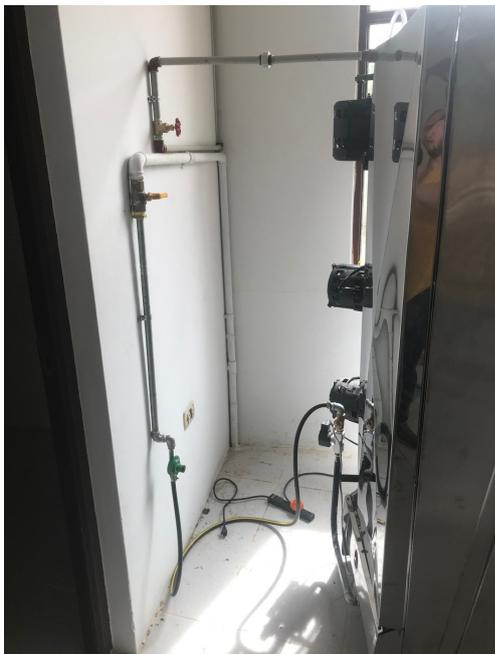
Le four industriel à chaleur tournante a déjà été installé (raccordement à l'eau et au gaz). Nous avons également reçu 30 plaques pour le four mais ce ne sont pas les bonnes. Nous devons les renvoyer et attendre les plaques adéquates.
